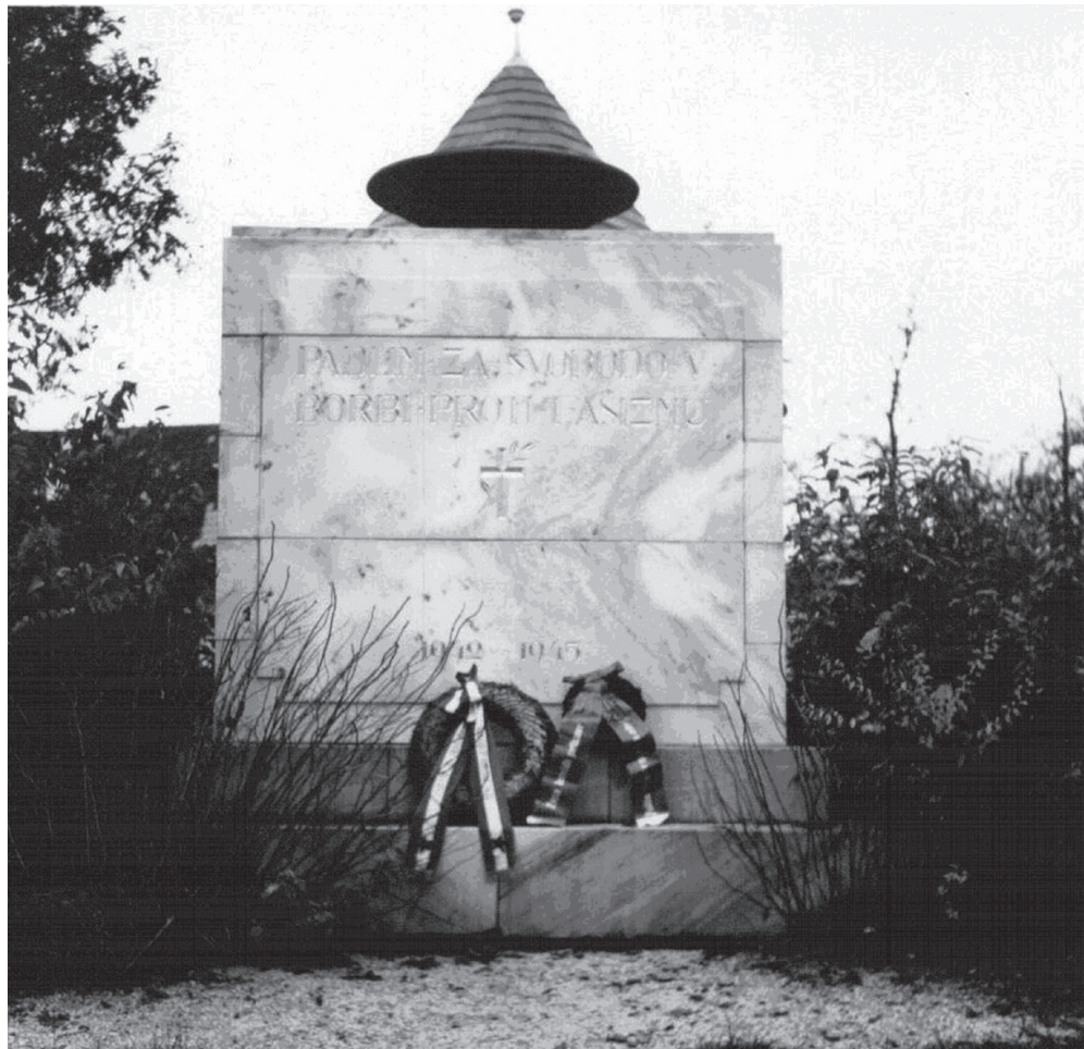
Abb. 9: Das neu gestaltete Denkmal am St. Ruprechter Friedhof, 1962.
